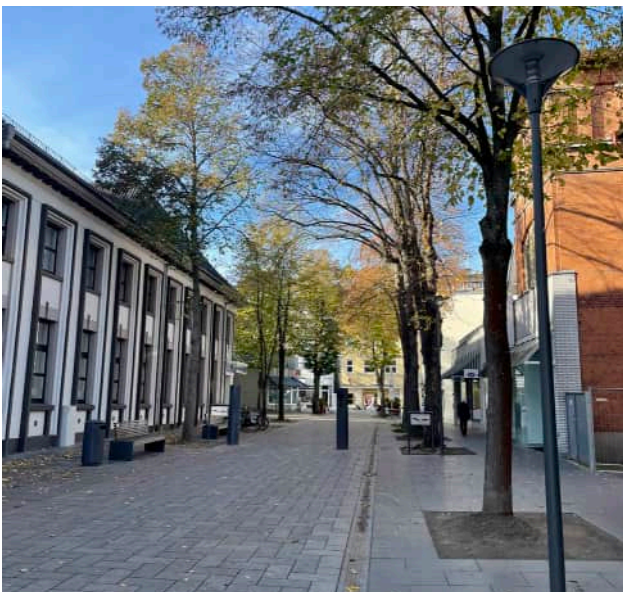
Umgestalteter Teil der Portastraße
